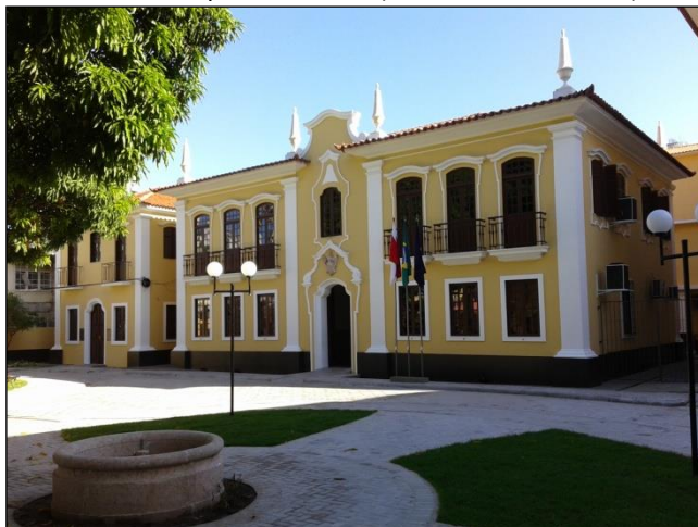
FIGURA 1 – Conservatório após a reforma (24 de Junho de 2015).
